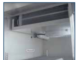
evaporador en el techo top mounted evaporator
