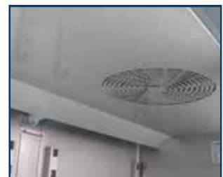
evaporador en el techo top mounted evaporator
